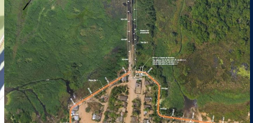
Obras de mitigación en centros poblados
