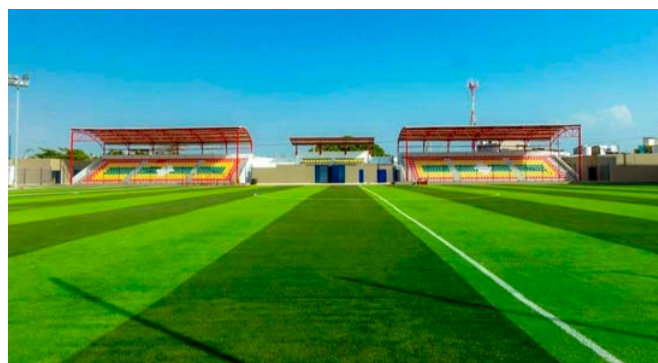
Renovación Estadio de San Fernando
