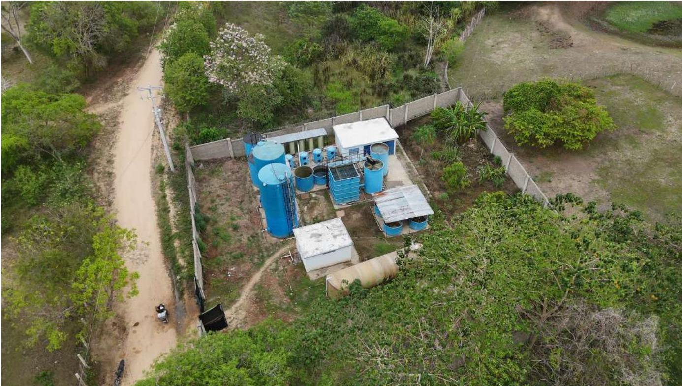
En la PTAP se cuenta con un pozo con capacidad de producir 5 lps, con una planta de tratamiento de agua potable de 7 lps y 2 tanques de almacenamiento semienterrados de 50m<sup>3</sup> cada uno.
