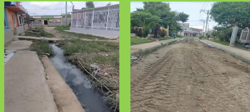
CUNETA SAN ANTONIO
