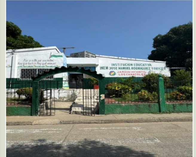
Adecuación y mejoramiento de la institución educativa «INEM - CARTAGENA»
