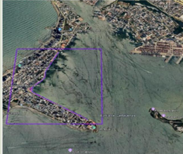
Construcción de obras para la prevención y control de inundaciones en los barrios de Bocagrande y Castillo Grande
